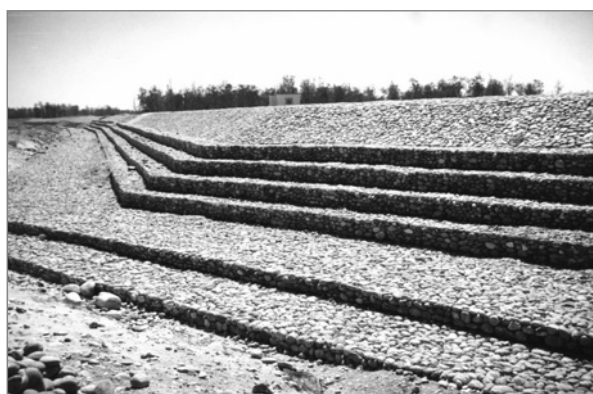
Figure 1.18 Digue longitudinale en gabion (source : M. MacDonald)
