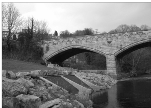
Figure 1.16 Protection en énrochement d'un émissaire d'évacuation (source : C. Rickard)
