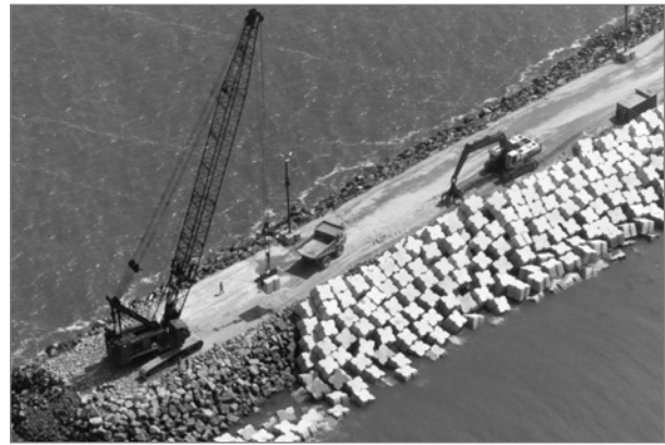
Figure 1.3 Construction d'une digue à talus composée d'une carapace en blocs artificiels (source : CUR)
