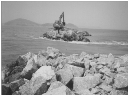
Figure 1.11 Fermeture en enrochement en construction (source : KARICO)
