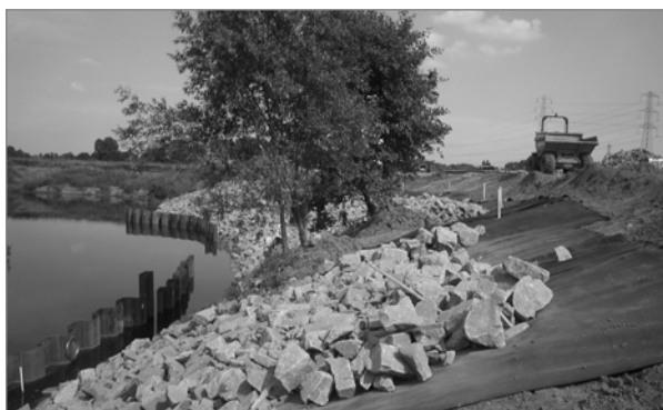
Figure 1.15 Revêtement en énrochement en construction sur un géotextile (source : M. MacDonald)
