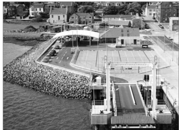
Figure 1.5 Protection en enrochement d'ouvrage por- tuaire (source : E. Nuttall)
