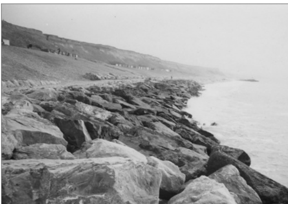
Figure 1.6 Revêtement en enrochement (source : HR Wallingford)
