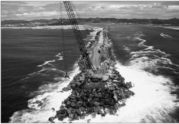
Figure 1.2 Digue à talus en enrochement naturel (source : B. Wegner, USACE)
