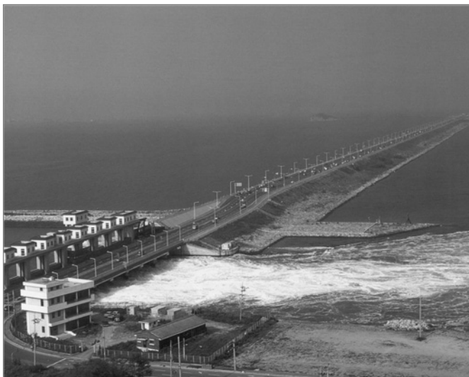
Figure 1.12 Digue de fermeture (source : KOWACO)
