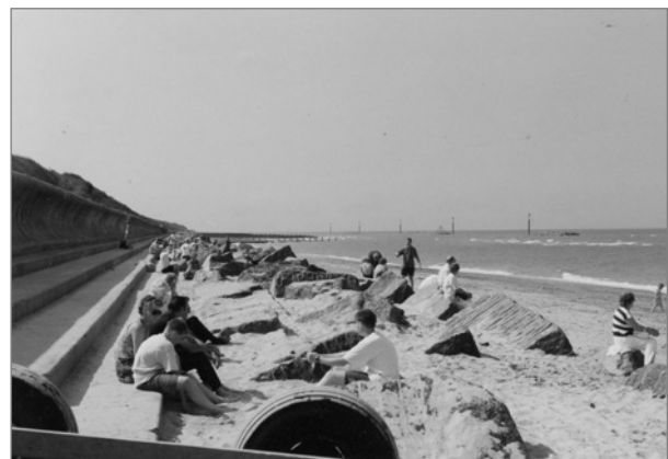
Figure 1.7 Protection anti-affoulement d'un mur de haut de plage (source : C. Orbell-Durrant)
