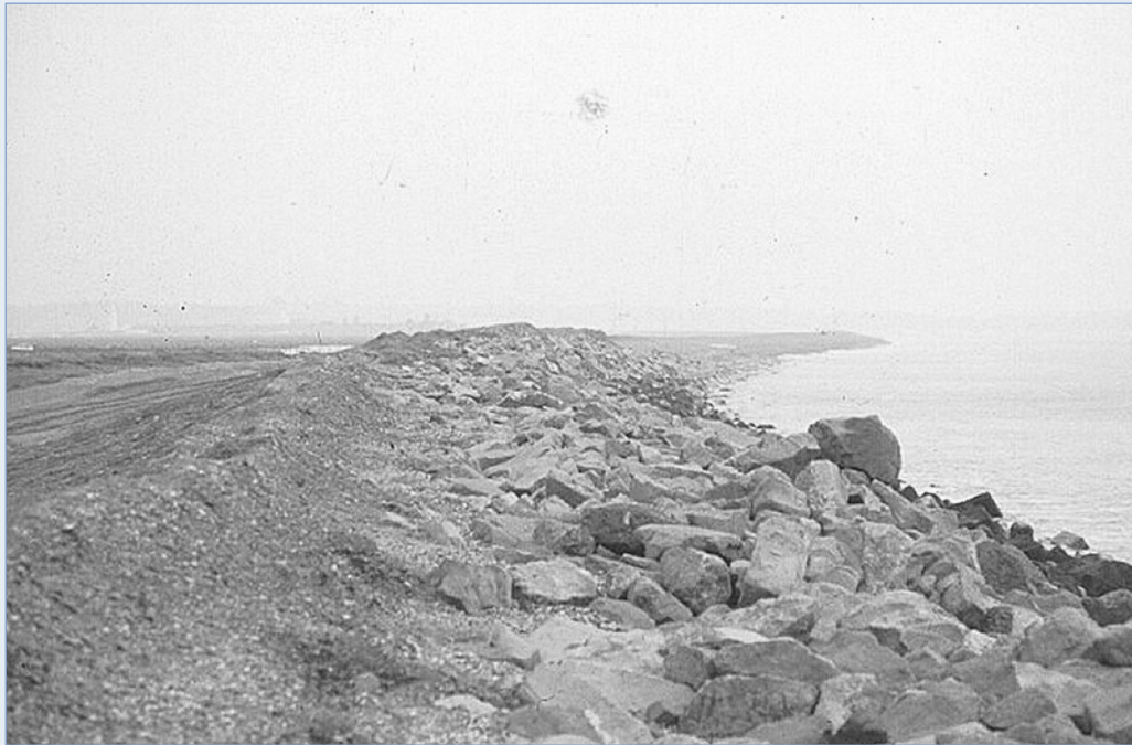
Figure 10.9 Revêtement en enrochement de Hurst Spit en décembre 1989, après une tempête qui l'a endommagé (source : A.P. Bradbury)
