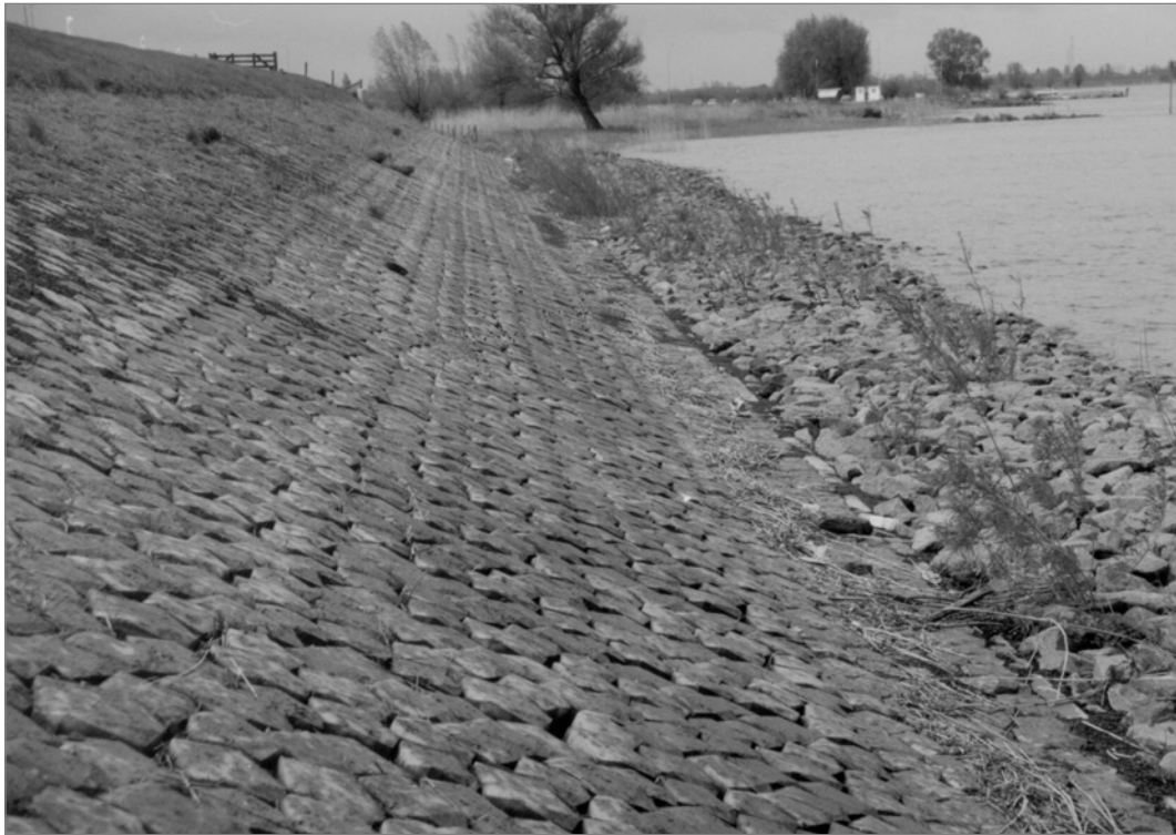
Figure 5.75 Butée de pied (ou berme au niveau de l'eau au repos) d'une digue fluviale (source : Rijkswaterstaat)
