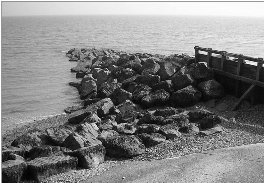
**Figure 6.44** *Épi en enrochement classique*
