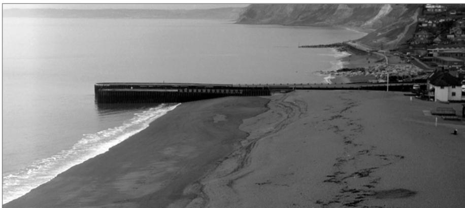
**Figure 6.50** Épi isolé de grande taille (jetée d'un port) qui piège les sédiments (source : HR Wallingford)
