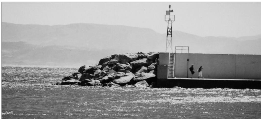
**Figure 6.9** Protection en enrochement au musoir d'une digue, contre un caisson vertical
