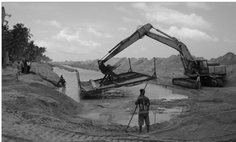
**Figure 6.56** Mise en place d'un géotextile à l'aide d'un cadre (source : HR Wallingford)
