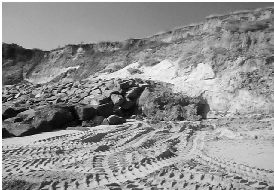
**Figure 6.73** Revêtement en engrochement naturel d'un pied de falaise (source : Halcrow)
