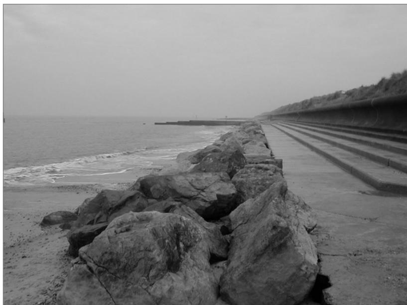
**Figure 6.43** Protection anti-affouillement d'un mur chasse-mer, Happisburgh, Royaume-Uni (source : Halcrow)
