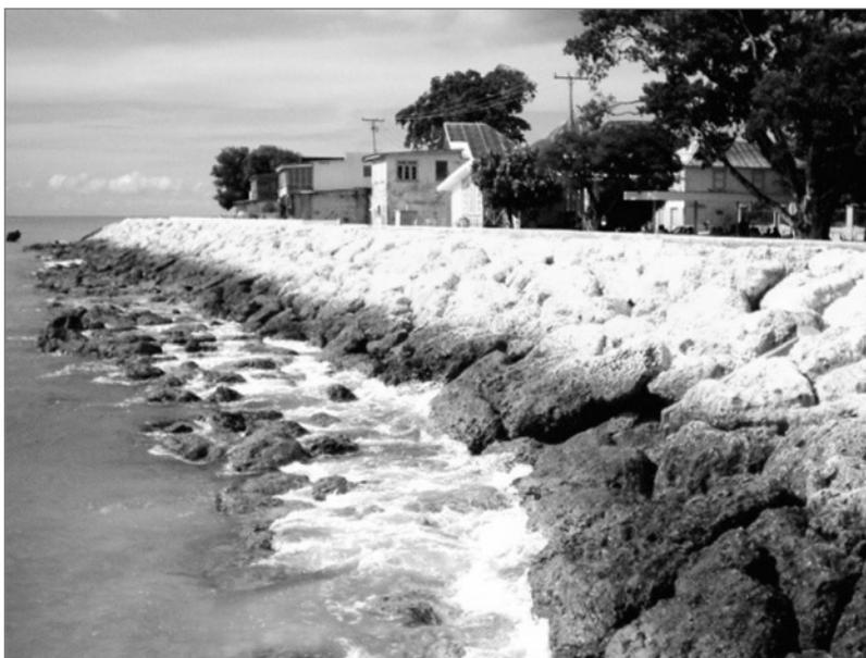
**Figure 6.55** *Exemple typique d'un site où le franchissement pourrait endommager les infrastructures locales*
