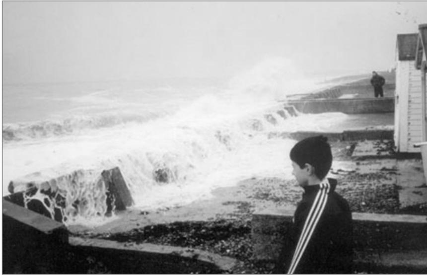
**Figure 6.54** *Franchissement d'un mur de haut de plage. Noter la présence de piétons et la proximité de petits bâtiments*
