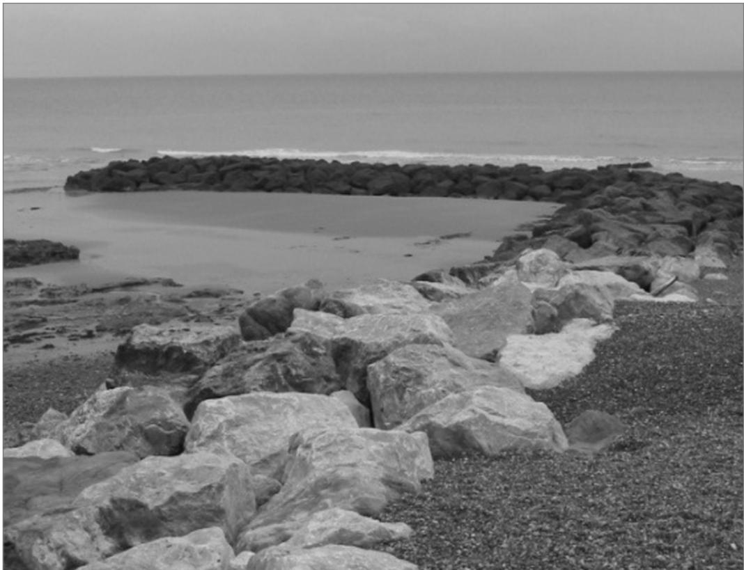
**Figure 6.47** Épi en L, Bulverhythe, Royaume-Uni (source: Halcrow)
