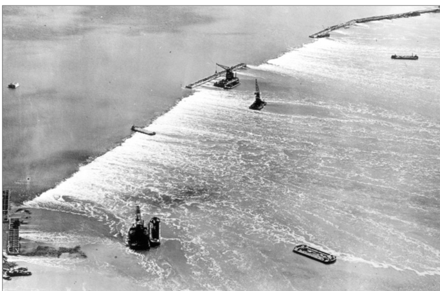
Figure 7.30 Protection du fond dans la fermeture superficielle de Schelphoek (1953), aux Pays-Bas (source : KLM)
