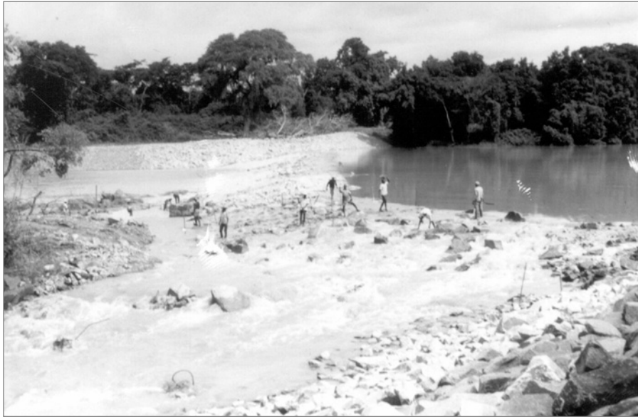
Figure 7.32 Barrage de Bajibo sur le Niger (source: J. van Duivendijk)
