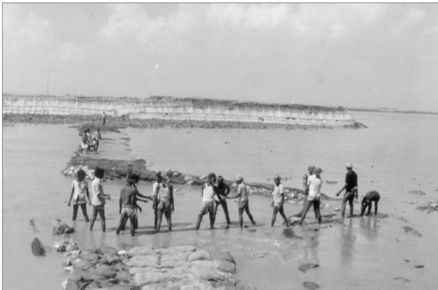
Figure 7.29 Seuil dans une fermeture d'estuaire construite sur la rivière Feni, au Bangladesh (source : J. van Duivendijk)
