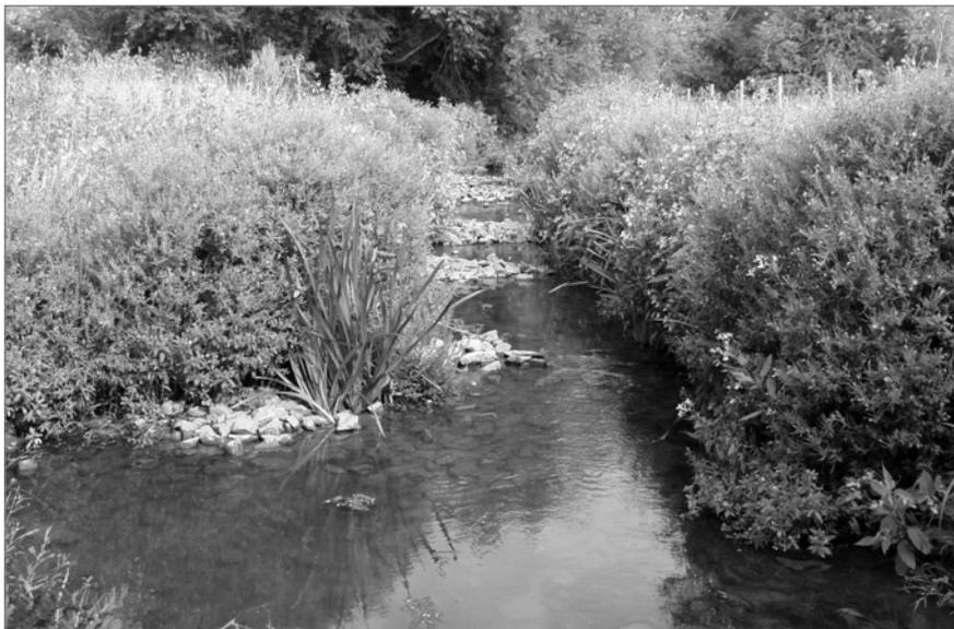
**Figure 8.5** *Enrochements mis en place dans un petit cours d'eau afin de stabiliser le lit et de créer des zones de courant (source : Mott MacDonald)*
