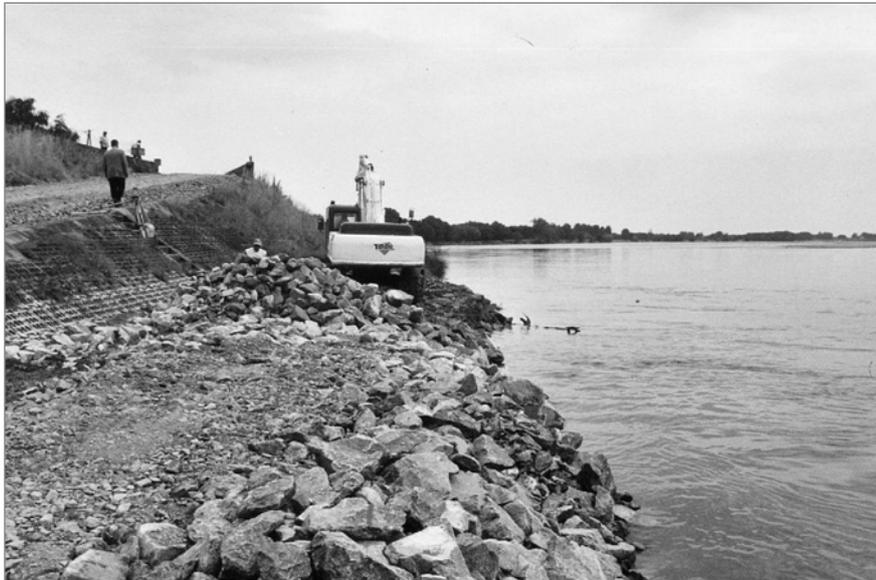
**Figure 8.14** *Digue de protection contre les crues construite le long de la Loire (ici en phase de réhabilitation) – vue de la protection anti-affouillement (source : TPPL-France)*
