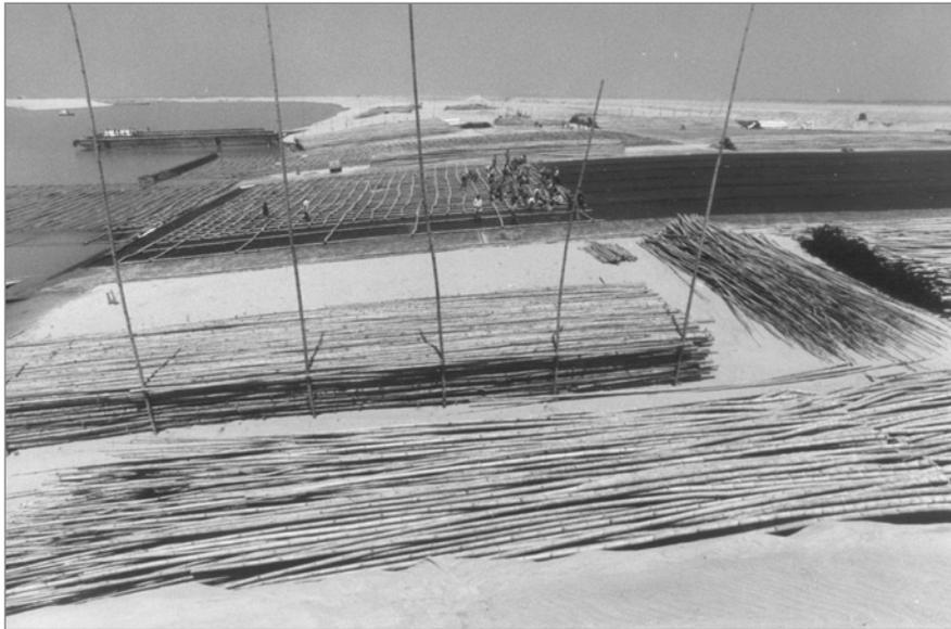
**Figure 8.6** Construction d'un matelas de fascines en vue du placement d'un géotextile
