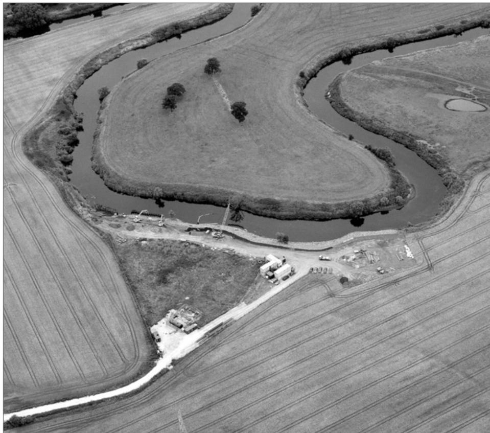
**Figure 8.44** Photographie aérienne d'un revêtement en enrochement mis en place pour arrêter l'érosion de la berge en direction de sols contaminés. L'alignement du revêtement suit la ligne de berge et s'ancre, aux deux extrémités, dans une section de berge plus stable. Il faut noter le maintien des arbustes qui poussent sur la rive (source : Mott MacDonald)
