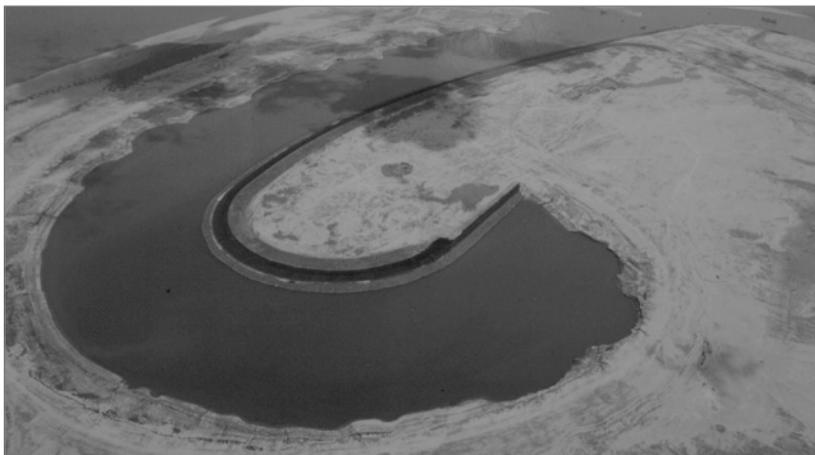
**Figure 8.3** Digue longitudinale de grande envergure construit avant le Pont de Jamuna, au Bangladesh (source : J. Van Duivendijk)
