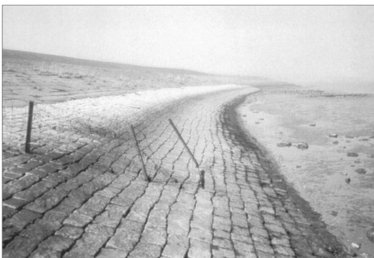
**Figure 8.7** Revêtement fait d'enrochements appareillés
