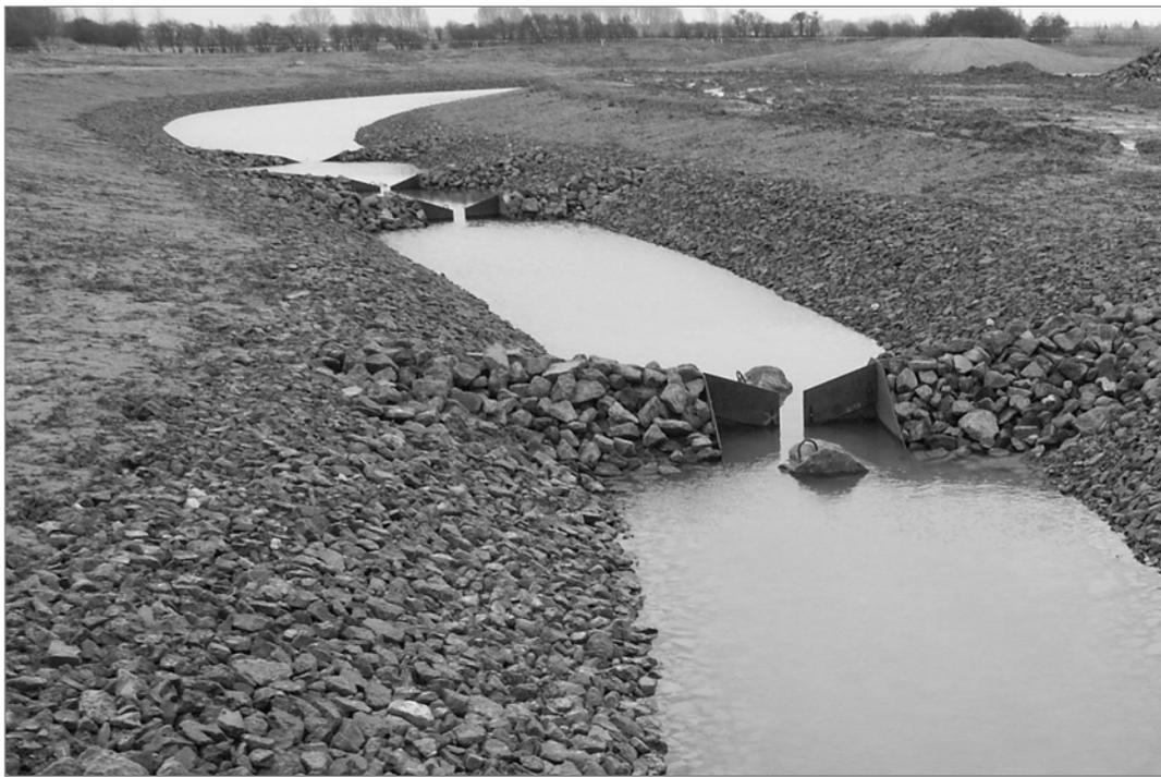
**Figure 8.49** Passe à poissons sur le Rhin, montrant des seuils en forme de V avec fente verticale
