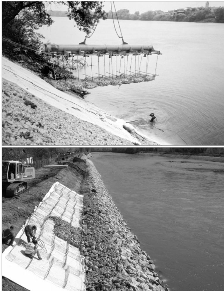
**Figure 8.59** Construction des revêtements en gabions sous l'eau ou à sec
