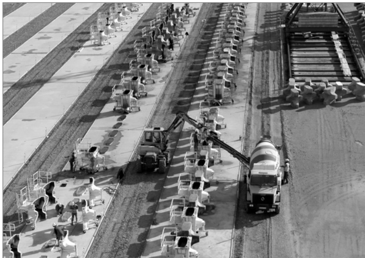
Figure 3.97 Exemple d'un site de préfabrication de blocs artificiels : préparation des moules (premier plan gauche); coulage et vibration (premier plan droit); décoffrage et cure (arrière-plan). (source : Port Autonome du Havre)
