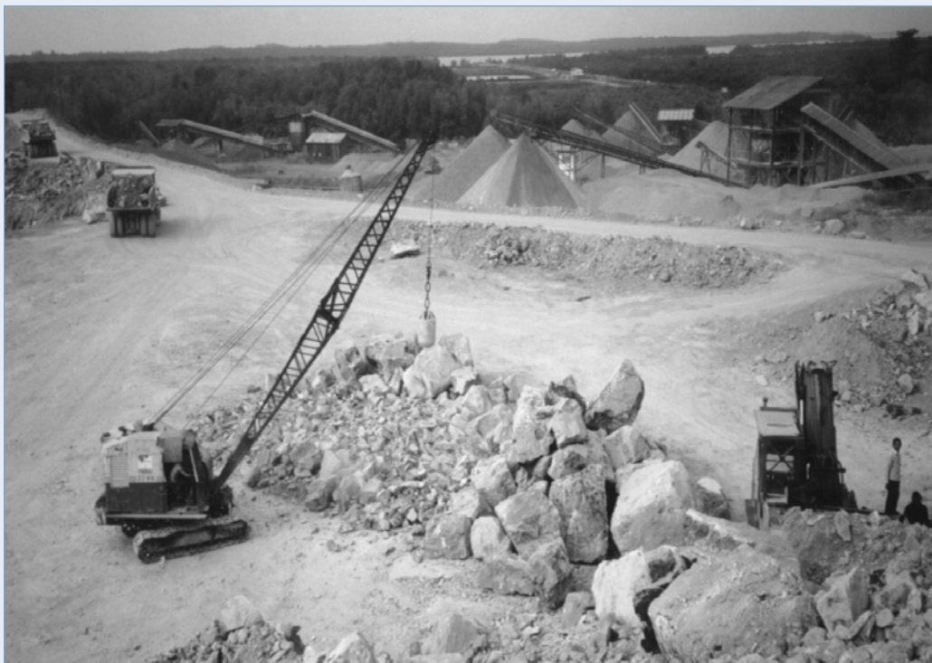
Figure 3.75 Grue sur chenilles avec un boulet de démolition en acier au manganèse
