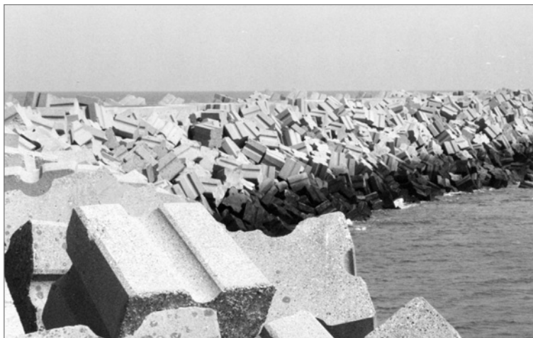
Figure 3.92 Exemple de cubes Antifer – Digue d'Antifer (source : S. Dupray)
