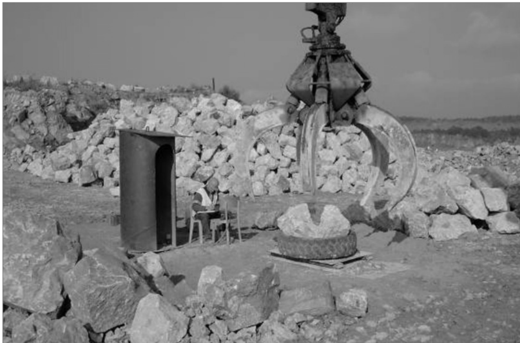
Figure 3.81 Contrôle des blocométries d'un enrochement 300-1000 kg au cours de la production, à l'aide de poutres de pesée (source : A. Moiset). Ce dispositif a permis de peser 140 blocs par heure.
