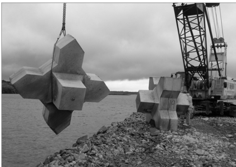
Figure 3.96 Exemple de manutention d'un bloc Xbloc (source : Delta Marine Consultants)
