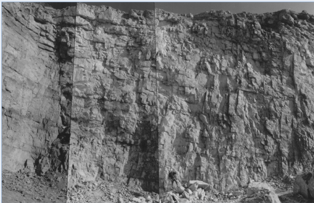
Figure 3.58 Fissuration verticale et stratification du front Est d'une carrière de calcaire. Remarquer la personne qui donne l'échelle
