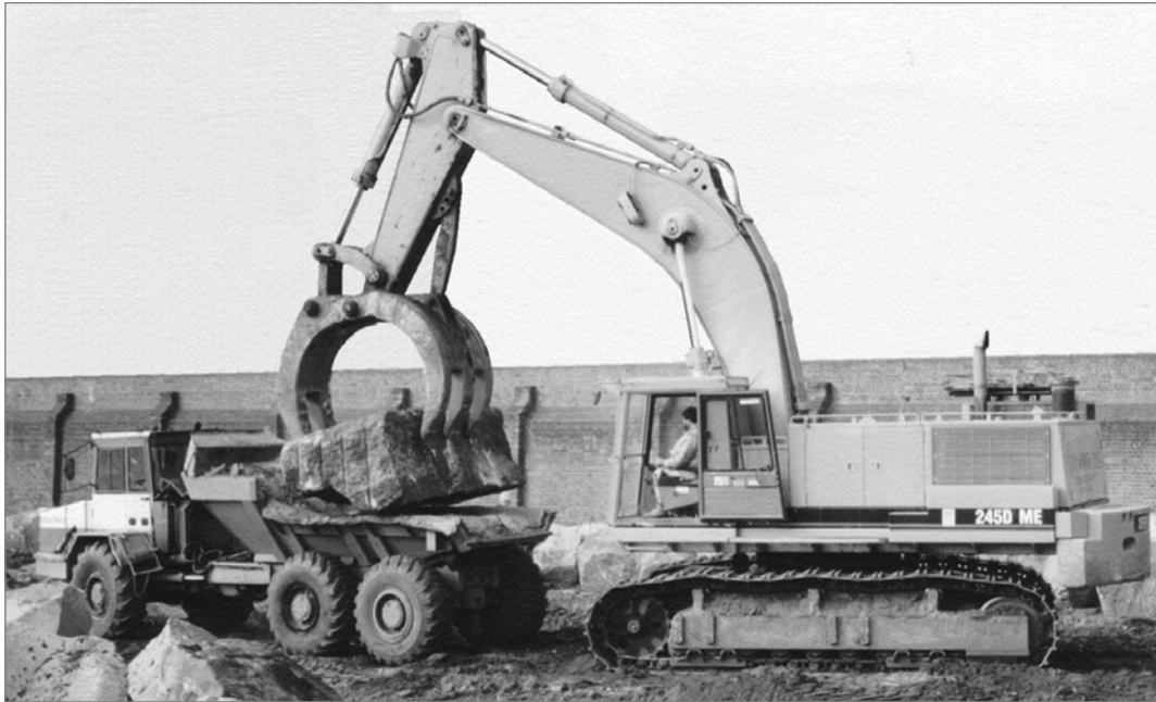
Figure 3.78 Utilisation de pelles pour la manutention d'enrochement. En haut à gauche : montée sur chenilles, elle dégage un front et trie les gros blocs (source : T. Wojnowski); en haut à droite : montée sur chenilles avec un godet ajouré qui sélectionne les blocs après fragmentation secondaire à l'aide d'un brise-roche hydraulique (source : S. Dupray); en bas : avec une pince à 5 dents de grande capacité pour la manipulation individuelle de gros blocs (Source : J. van Meulen).
