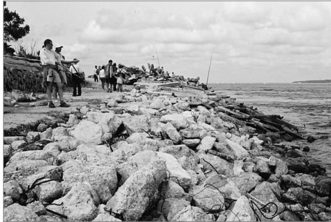
Figure 3.99 Exemple de l'utilisation du béton concassé dans une digue
