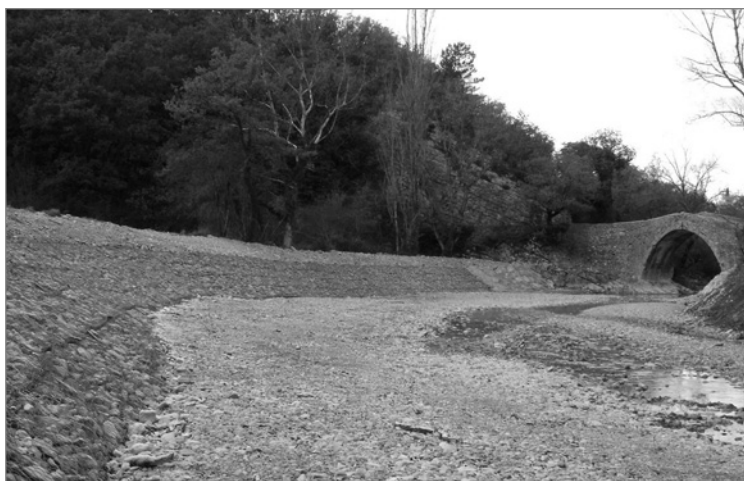
Figure 3.107 Protection en gabions du lit d'une rivière - la berge n'est exposée à l'attaque des courants qu'en cas de crue
