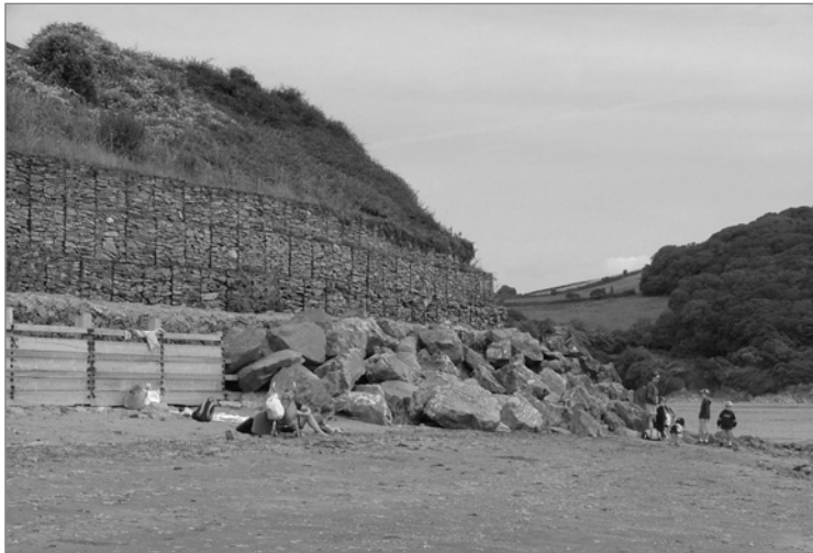
Figure 3.108 Gabions placés derrière la carapace principale
