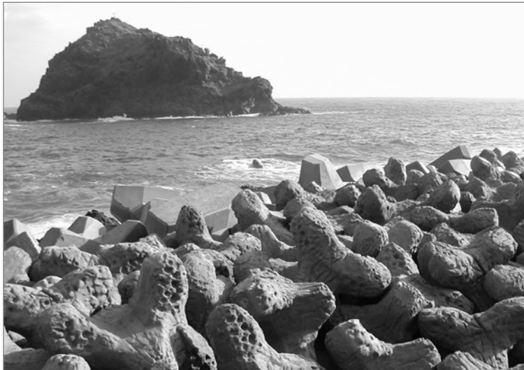
Figure 3.95 Exemple d'utilisation d'une combinaison de blocs ACCROPODE et ECOPODE (source : Sogreah)
