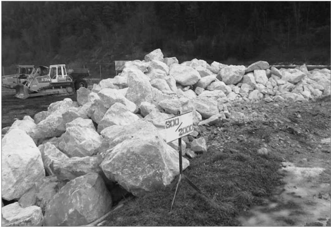
Figure 3.86 Vue d'un stock temporaire de blocs de 800-2 000 kg où la contamination par des fines et par le sol est visible (source : S. Dupray). Le panneau à l'avant porte des indications claires de la blocométrie. Cela permet aux conducteurs de déposer leurs chargements dans les stocks qui conviennent.
