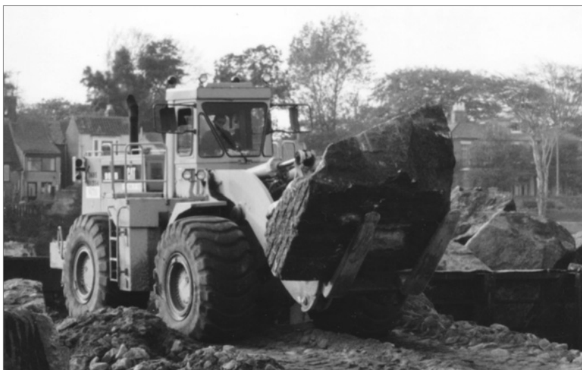
Figure 3.79 Chargeuse équipée d'une fourche pour la manutention de gros enrochements (Source : J. van Meulen)
