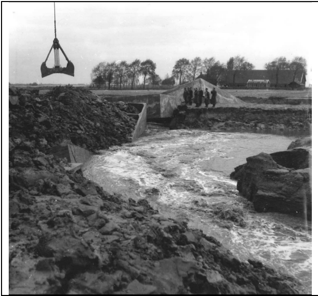
Sluiting met de bodemloze caissons
