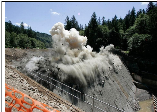
Sloop van een dam (gebouwd voor opwekking van waterkracht; bij de bouw is hier niet over nagedacht oplazen Marmot Dam in de Sandy River in Oregon, 2007 (Wikipedia)
