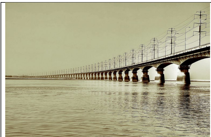
Jamunabrug in Bangladesh
