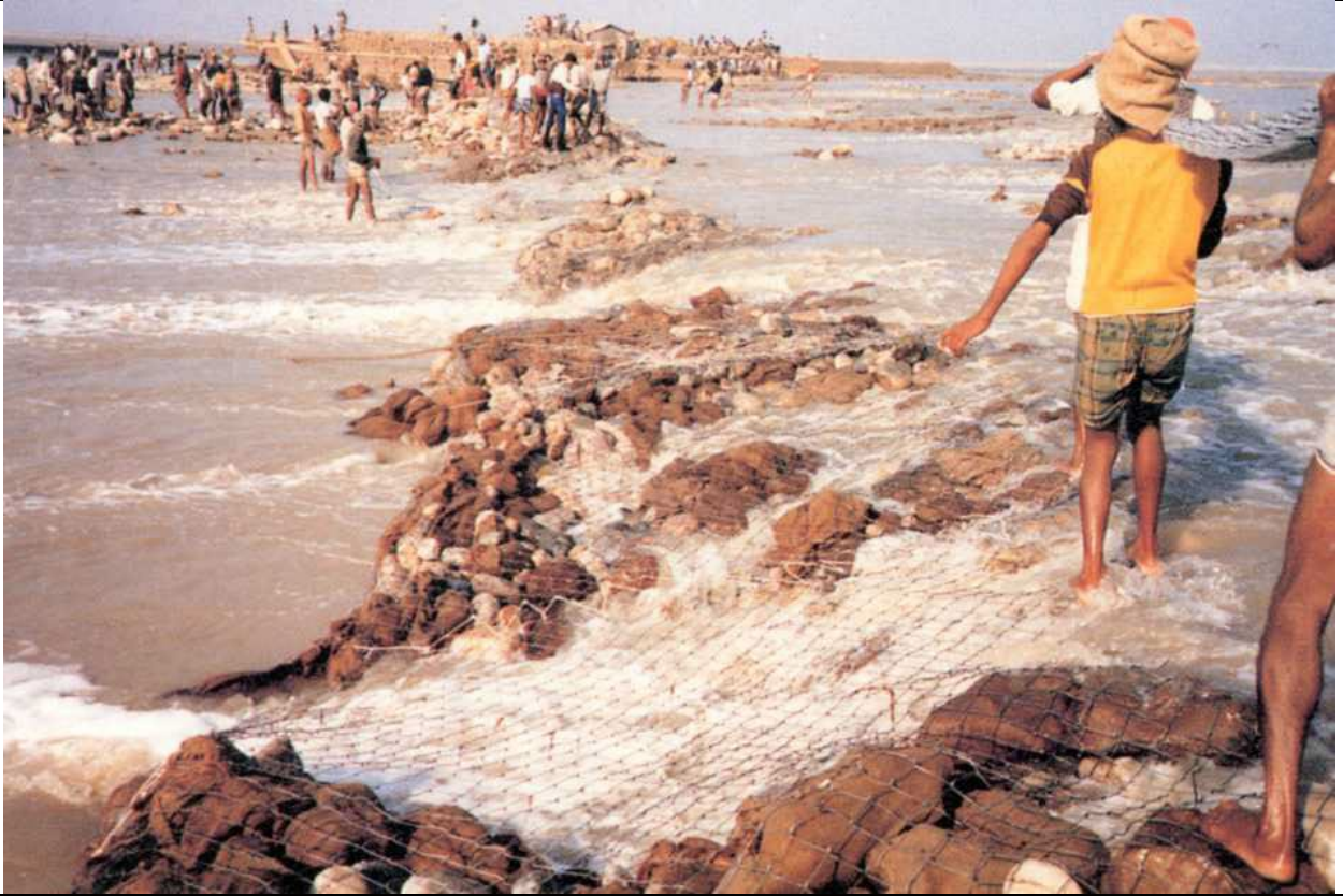
Gebruik van lokaal gemaakte schanskorven bij een sluiting van een getijgeul in Bangladesh Archief TU Delft
