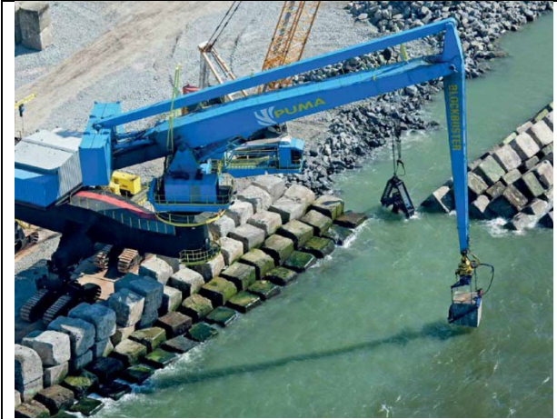
Herplaatsen van 40 tons betonblokken bij de Maasvlakte
