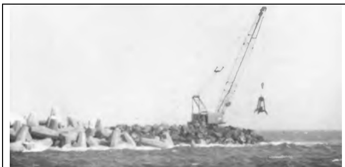
Bouw van de golfbreker van Sines met grote Dolosse Foto: Baird et al. Report on the Damages to the Sines Breakwater, Portugal, 1980
