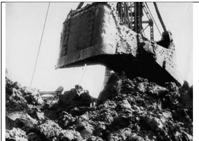
Het gebruik van keileem bij de Afsluitdijk 1932, foto Beeldbank RWS
